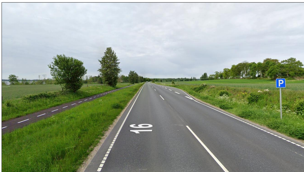
Figur 5. Amtsvejen (rute 16) ca. 1 km. vest for Hanehoved klassificeret som 'Trafikvej, gennemfartsvej' (Kilde: Google Maps, maj 2021).
