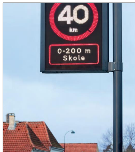
Figur 12. Variabel hastighedstavle ved skole. Tavlen slukker udenfor skoletiden. 1
